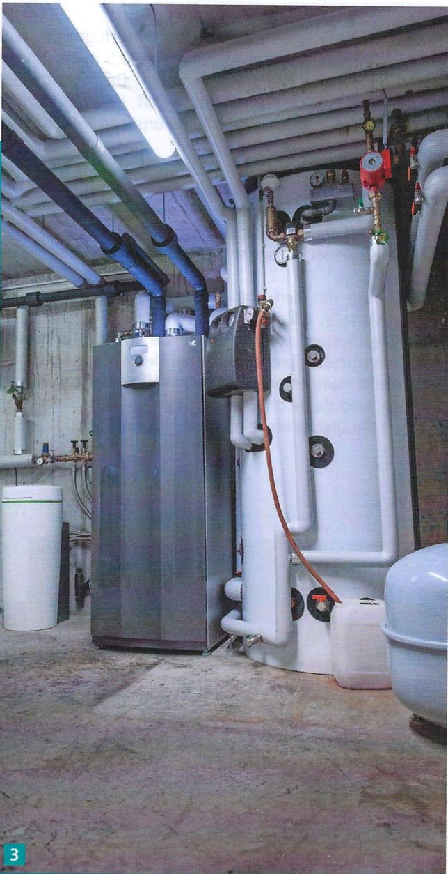
3 Die drehzahlgeregelten Wärmepumpen von alpha innotec vom Typ „SWCV 92K3“ wurden, um einen hohen Warmwasserkomfort sicherzustellen, mit einem 300-Liter-Warmwasserspeicher kombiniert.
