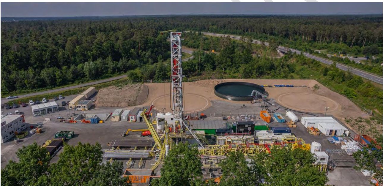
Abbildung 27: Drohnenaufnahme des Bohrplatzes in Graben-Neudorf (Deutsche ErdWärme GmbH, 2022)
